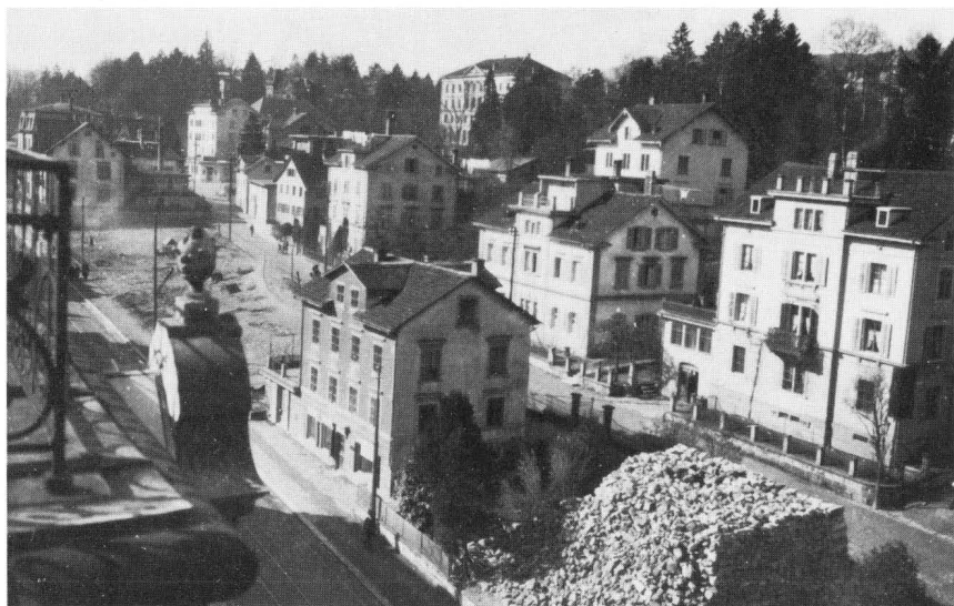
Blick von der Seestrasse Richtung Wollishofen auf den nördlichen Tunnelabschnitt Wollishofertunnel (Tagbaustrecke). Die im betroffenen Areal befindlichen Wohnhäuser sind teilweise abgebrochen (Berbig's Haus am linken Rand, oben). Zustand um 1923/24.
